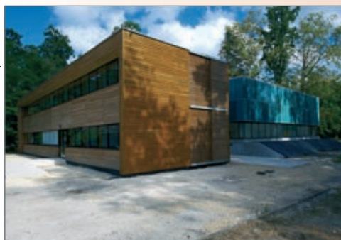
Ossature bois et bardage en pin maritime et peuplier rectifié pour l'extension des bureaux de BIOGECO livrée en septembre 2009.
