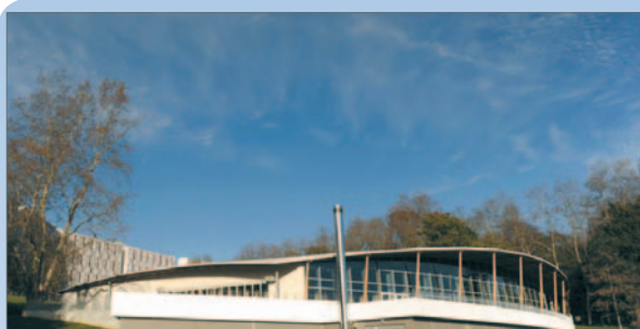
Le centre aquatique est au cœur du programme de revalorisation du quartier des Hauts-de-Bayonne
